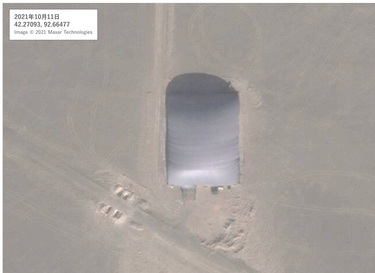
図1 サイロ建設現場に設置されたエアテント
